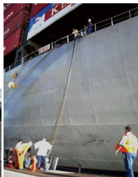
本船から降ろした電源ケーブル
