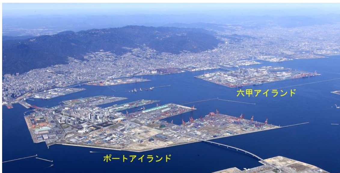
<図表 2> 神戸港コンテナターミナル全景
