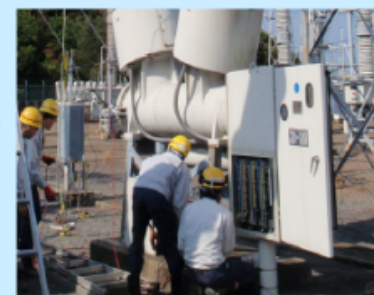
220 kVガス遮断器外部点検 (制御盤点検)
