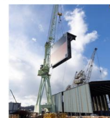
ジブクレーン(吊能力が低い)
