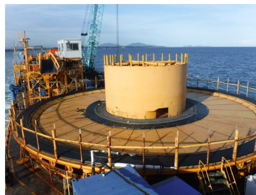
ケーブル敷設
