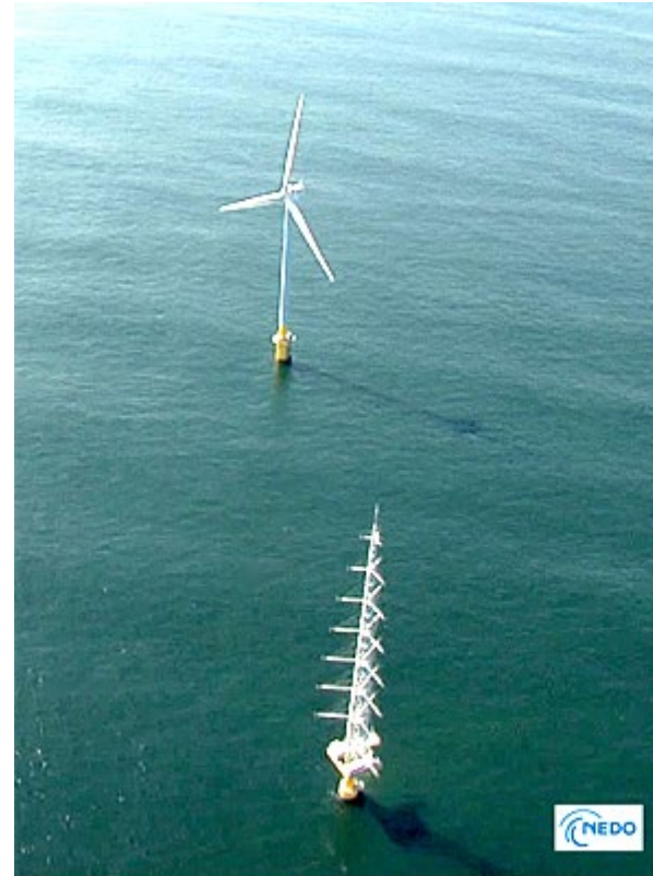
銚子沖の洋上風車・観測タワー (定格出力：2.4MW、発電開始：2013年3月)
