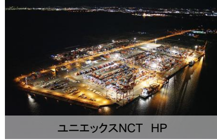
ヤード照明のLED化
