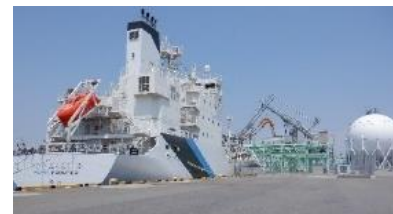
液化水素のサプライチェーンの構築に必要な港湾施設の整備
