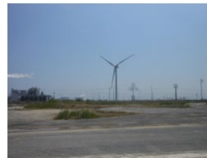
陸上に設置された風車
