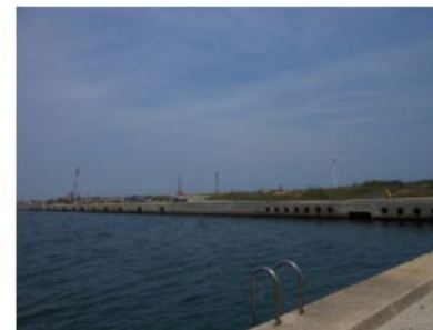
整備中の基地港湾予定地
