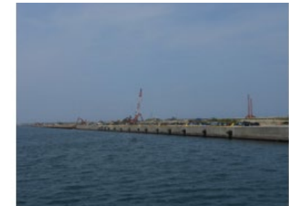
護岸工事の様子
