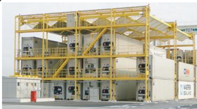
屋根付きRF施設 導入 (2010年)
