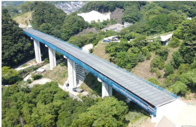
長崎南環状線3号橋（長崎市）
