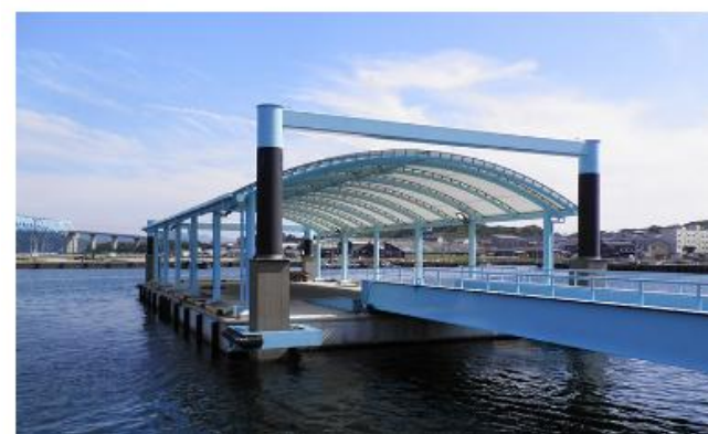
館浦漁港浮棧橋（平戸市）
