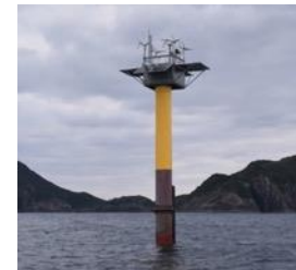
浮体式風況観測塔の開発
