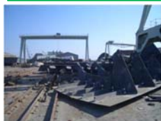
船ヤマニシ(石巻市): 全面にわたって地盤沈下。建屋の1階部分が損壊しており、受電設備等は全壊。施設内に建造中のブロックが散乱。
