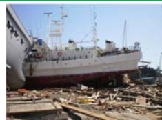
木戸浦造船所(気仙沼市): 船台のレールが曲がり、引揚ができない状況。建屋の1階部分は損壊しており、受電設備等は全壊。左の船は、隣の吉田造船工所から流出。
