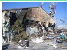
船ヤマニシ(石巻市): 全面にわたって地盤沈下。建屋の1階部分が損壊しており、受電設備等は全壊。施設内に建造中のブロックが散乱。
