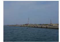
護岸工事の様子
