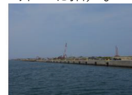
護岸工事の様子
