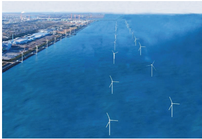
(出典)(株)ウィンド・パワー・エナジーホームページ
