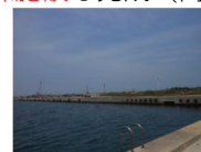
整備中の基地港湾予定地
