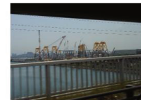
ジャケット式風車基礎
