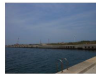
整備中の基地港湾予定地
