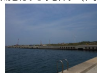
整備中の基地港湾予定地
