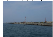
護岸工事の様子+
