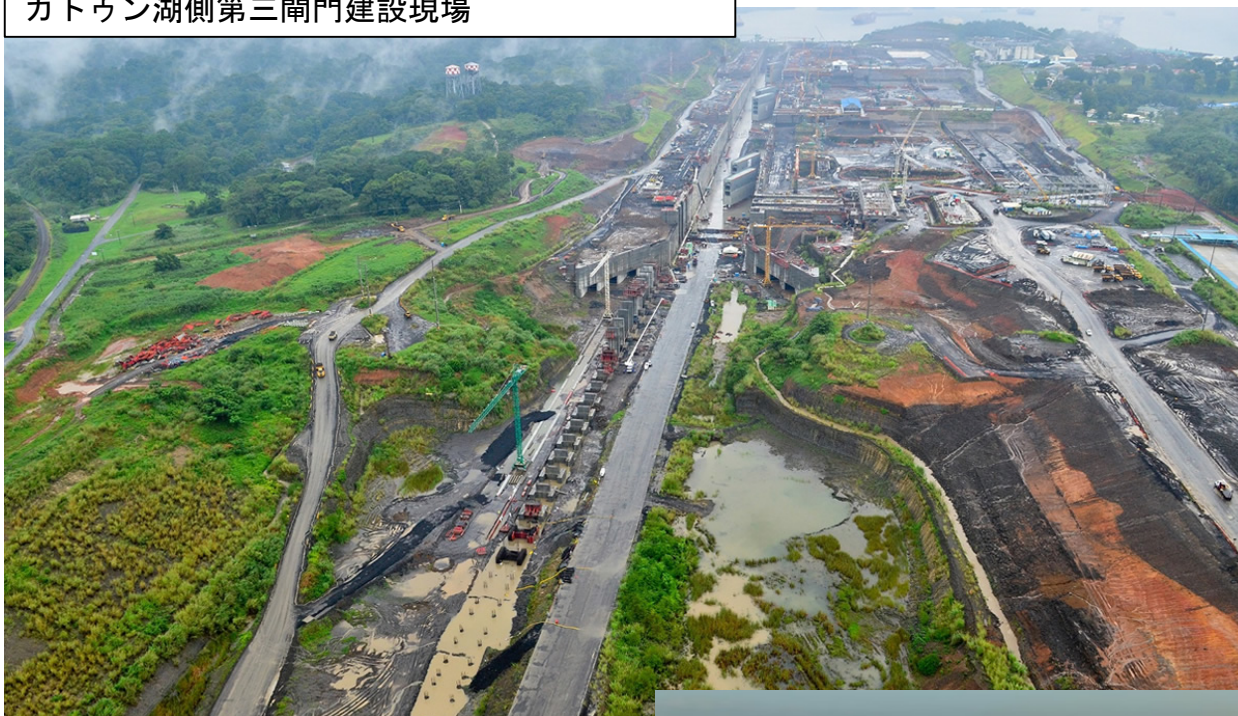
ガトゥン湖側第三閘門建設現場
