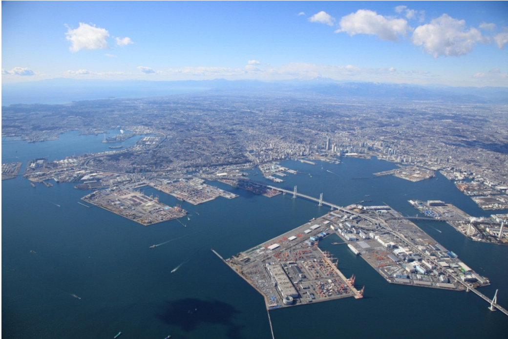
【横浜港の全景】
